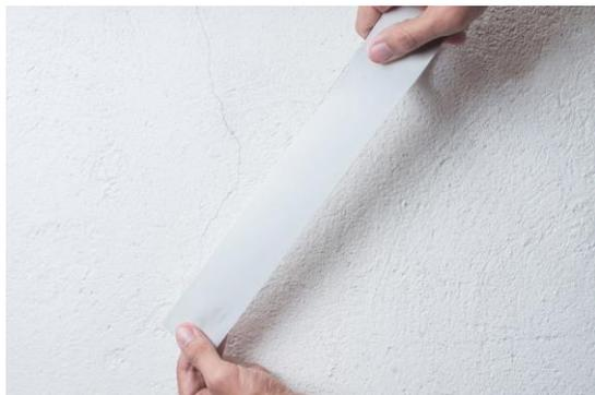
Corte a **FITAFIX<sup>®</sup>** no comprimento da fissura.
